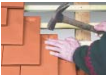
Fixation des tuiles en plain carré, par clou lorsque la zone, le site ou la pente le réclame.
