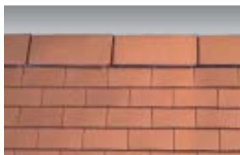
Faîtage réalisé à sec avec faitières / arêtiers angulaires à emboîtement et closoir ventilé, sans emploi de mortier.
